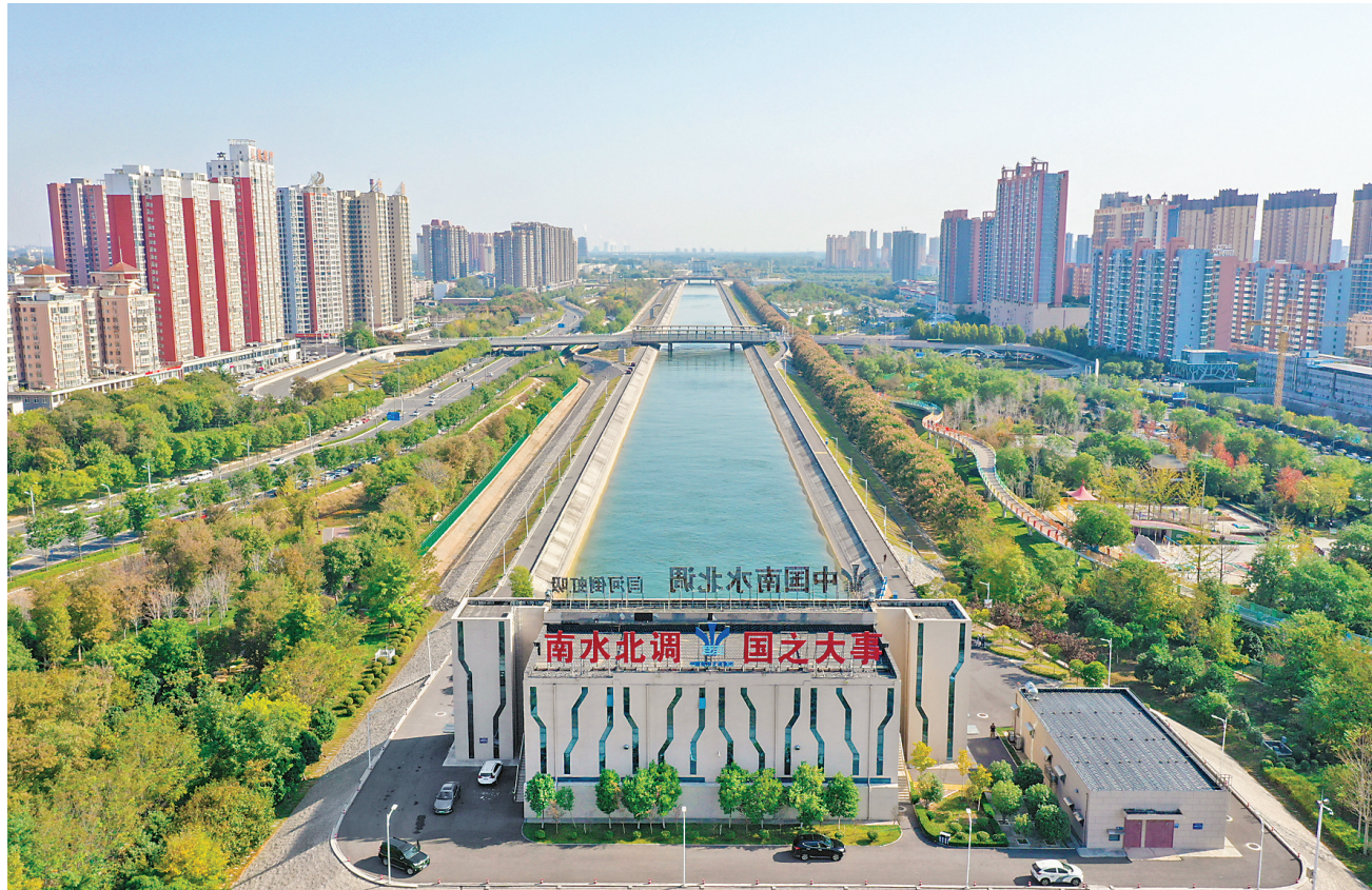
河南省焦作市区南水北调干渠及两岸风景(11月5日摄,无人机照片)。
