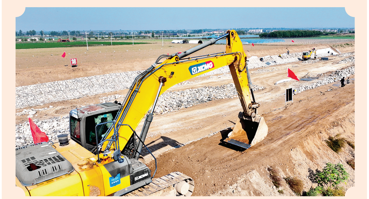
11月6日,在青龙河夏县段防洪能力提升工程工地上,工人们正在紧张地施工。青龙河夏县段防洪能力提升工程是夏县十大标志性、牵引性工程之一,包含堤防、防护、道路修筑等建设内容。工程建成后,不但能够提升防洪能力,守护人民群众生命财产安全,还可以改善生态环境,方便群众出行。特约摄影 姚中吉 摄
