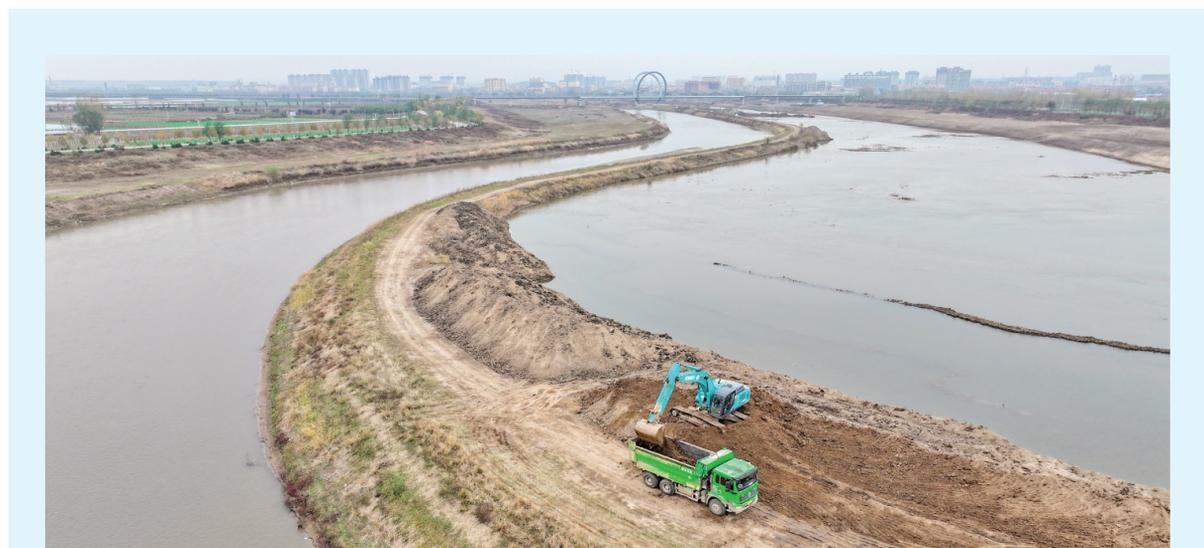
11月19日,施工人员在汾河干流程山城区段拓宽主河槽和清理河道淤泥。近年来,稷山县持续加快汾河干流程山段防洪能力提升工程建设和汾河流域生态修复治理,恢复水道通畅,降低洪涝灾害风险,促进汾河流域可持续发展。特约摄影 栗卢建 摄
