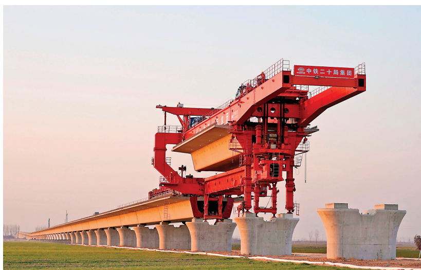
12月20日,中铁二十局工人在河北省邢台市清河县施工现场作业。冬日里,雄(安)商(丘)高铁建设施工单位围绕冬季施工要求,建立气温变化预警机制,开展生产人员冬季施工专项培训,有序推进工作。雄商高铁是我国高速铁路网“八纵八横”之京港(台)通道的重要组成部分,正线全长552公里,设计时速350公里。 新华社记者 邢广利 摄
