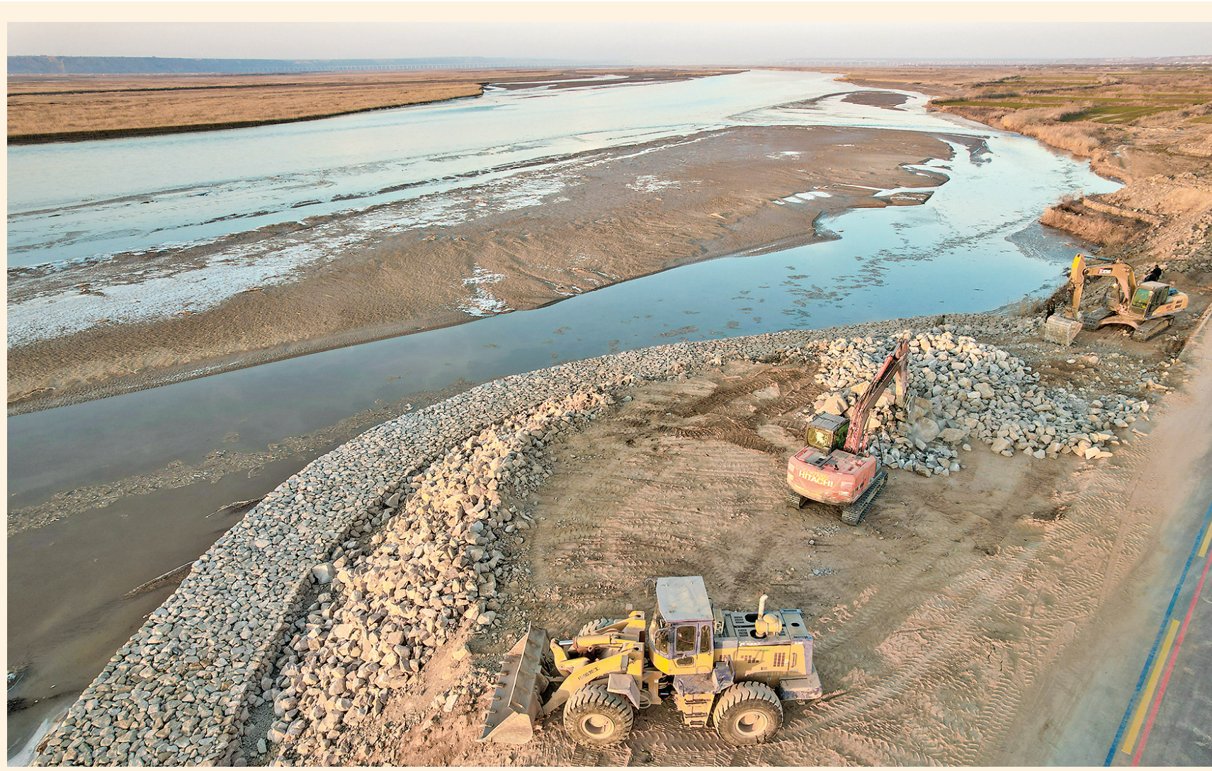
▲12月21日，工人操作机械在黄河永济舜帝坝段进行护岸除险加固作业。
