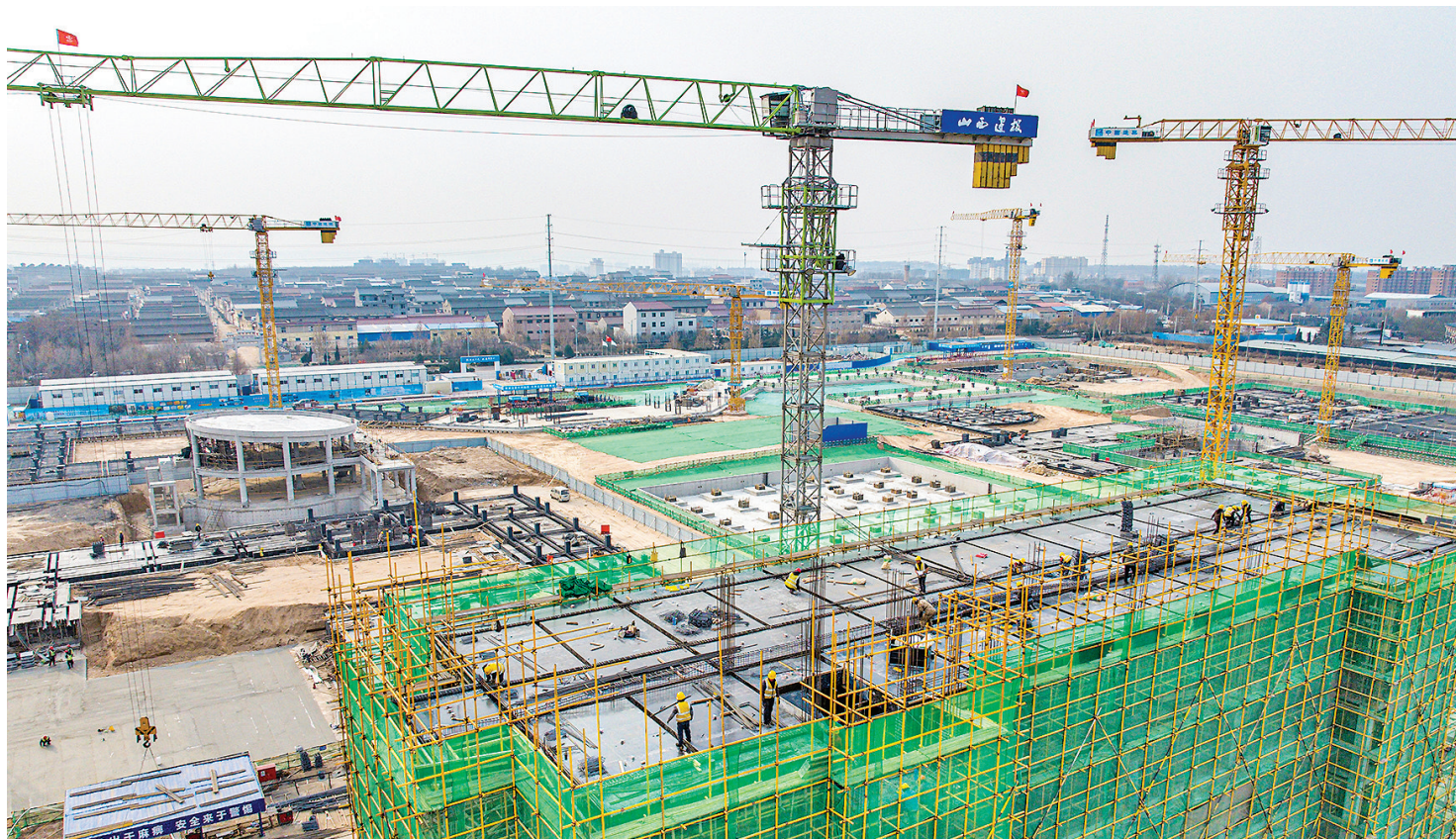
▲12月25日,天津市龙门学校建设项目(中学部)施工现场,工人们在加紧施工。
