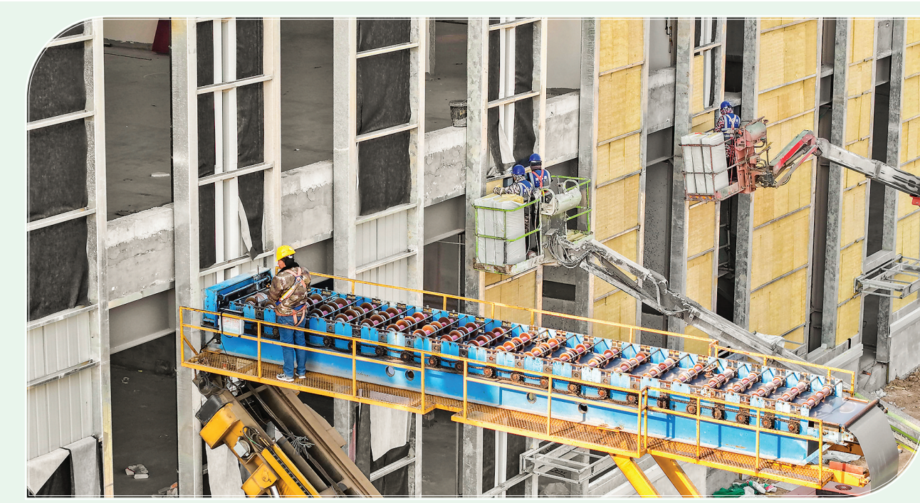
▲12月23日,运城保税物流中心项目建设现场,工人们在加紧施工。 据了解,该项目占地面积14.6公顷,总投资7.44亿元,建筑面积14.52万平方米,按照“整体规划,分步实施”的模式建设。目前,施工单位正在加紧推进一期工程,建设内容包括卡口、综合办公楼、查验仓、冷链仓、保税仓、堆场和室外基础设施,总投资3.57亿元,预计2025年2月底达到封关运行条件。 保税物流中心作为开放型经济的重要平台,对我市完善城市功能、扩大对外开放、提高城市知名度、拉动区域经济发展影响深远、意义重大。 本报记者 金玉敏 摄
