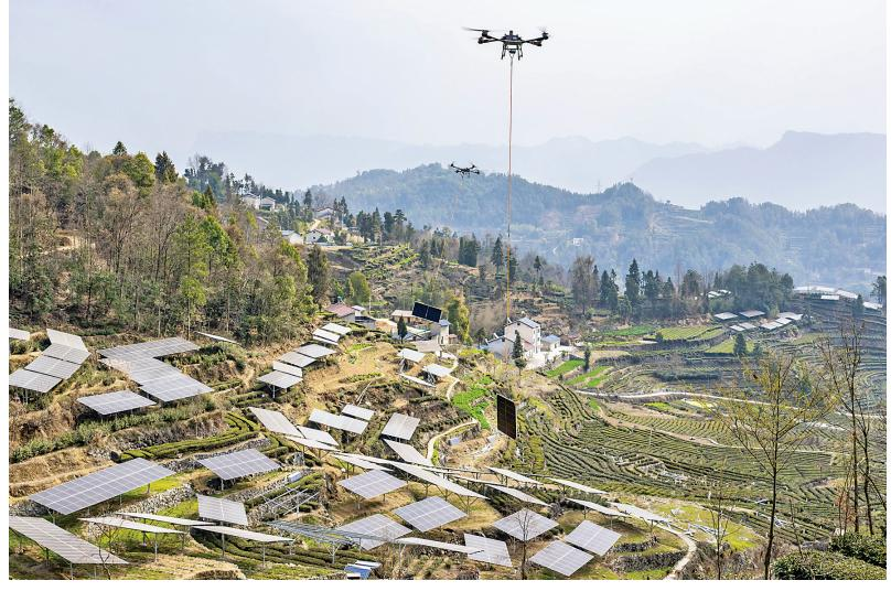
2月13日，技术人员在湖北省宜昌市秭归县茅坪镇花果园村光伏电站建设现场用无人机吊装光伏板（无人机照片）。
