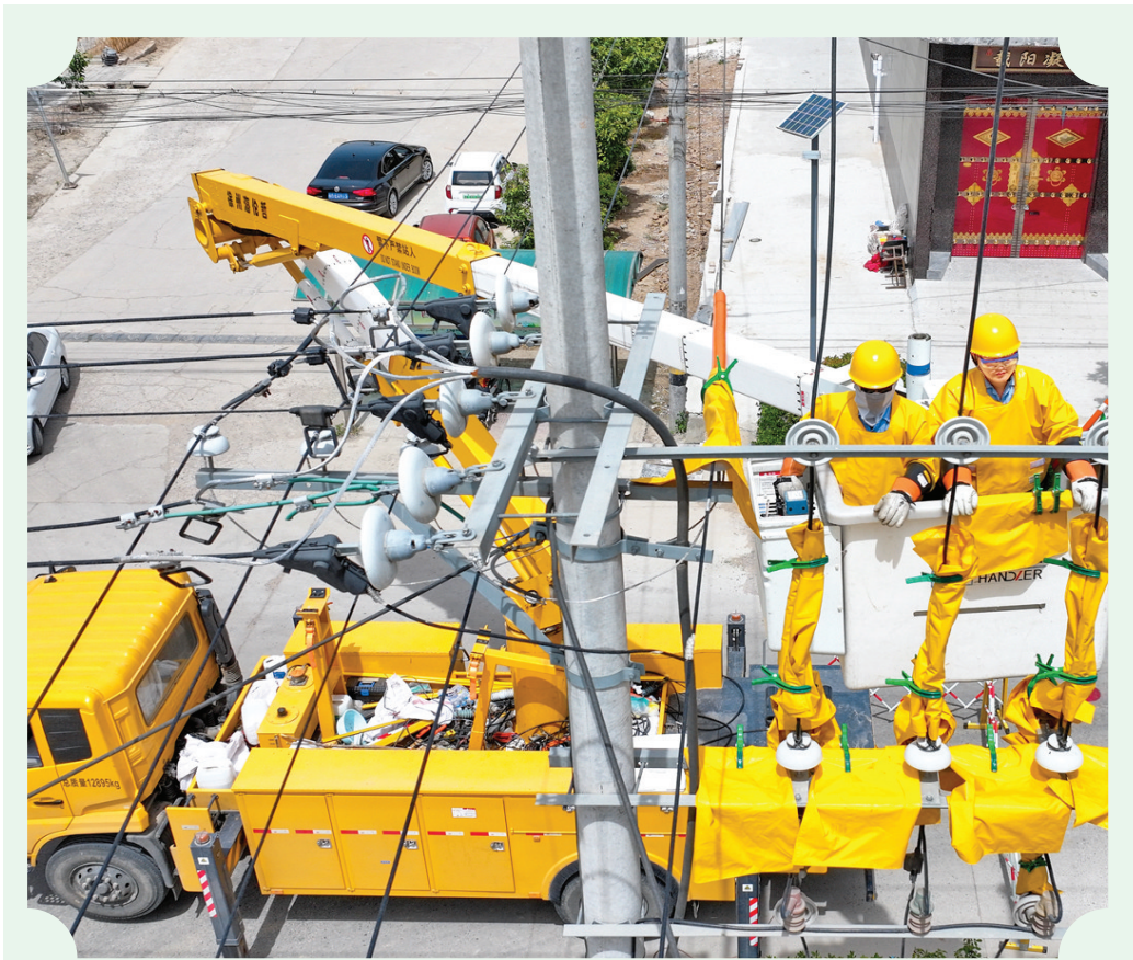
▲5月6日，国网夏县供电公司禹王供电所通过不停电作业方式在夏县西秦村更换跌落保险，确保线路安全运行、可靠供电。
