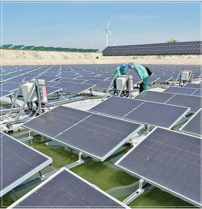
5月15日,国网故城县供电公司的工人在辖区三朗镇居召村一处渔光互补发电场检修并网线路。
