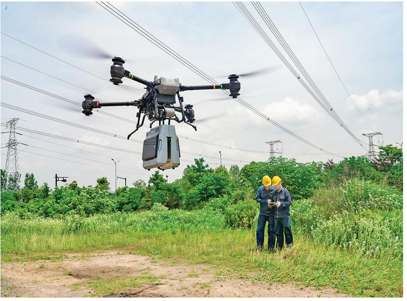
5月22日,在位于绍兴诸暨市的500千伏线路现场,工作人员操作搭载了地线断股带电修补机器人的大疆无人机起飞,对线路进行修复。
