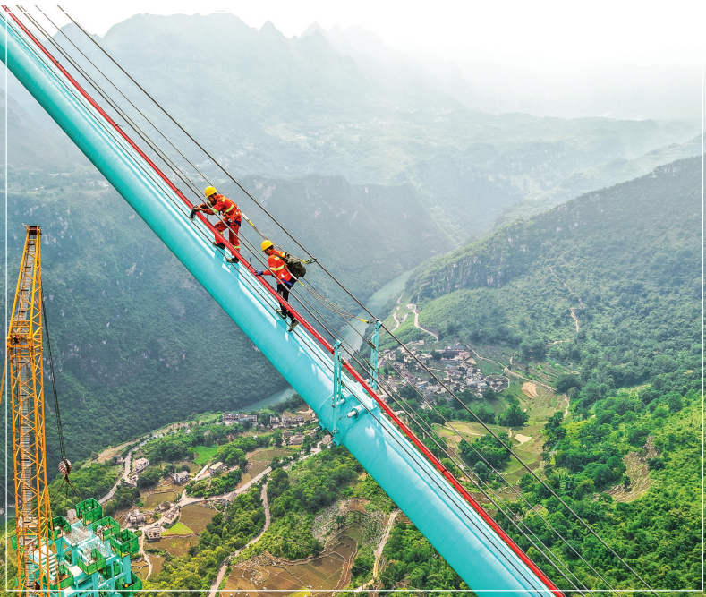
▲6月6日,工人在贵州花江峡谷大桥主缆上施工。 花江峡谷大桥是贵州六安高速公路的控制性工程,全长2890米、桥面距水面高625米,预计今年下半年建成。大桥建成后,将成为世界第一高桥,擦亮中国基建新名片。 新华社记者 杨文斌 摄
