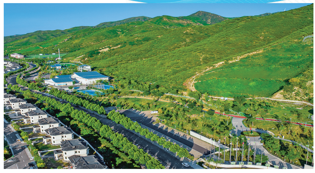
南山新境市民广场南侧山体修复项目建设内容包括坡面整形、挂网锚杆、植被喷播绿化等工程，已全部完工。经修复，裸露山体已披上绿装。
