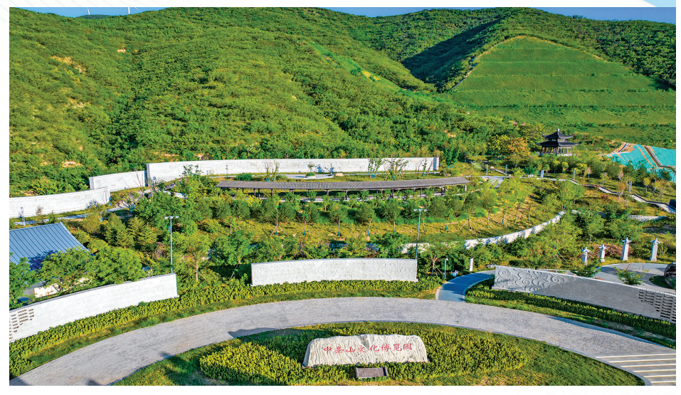
中条山废弃露天矿山生态修复项目位于中条山凤凰谷以西、西姚村以南，实施了边坡整治、场地平整、截排水沟等工程，已全部完工。
