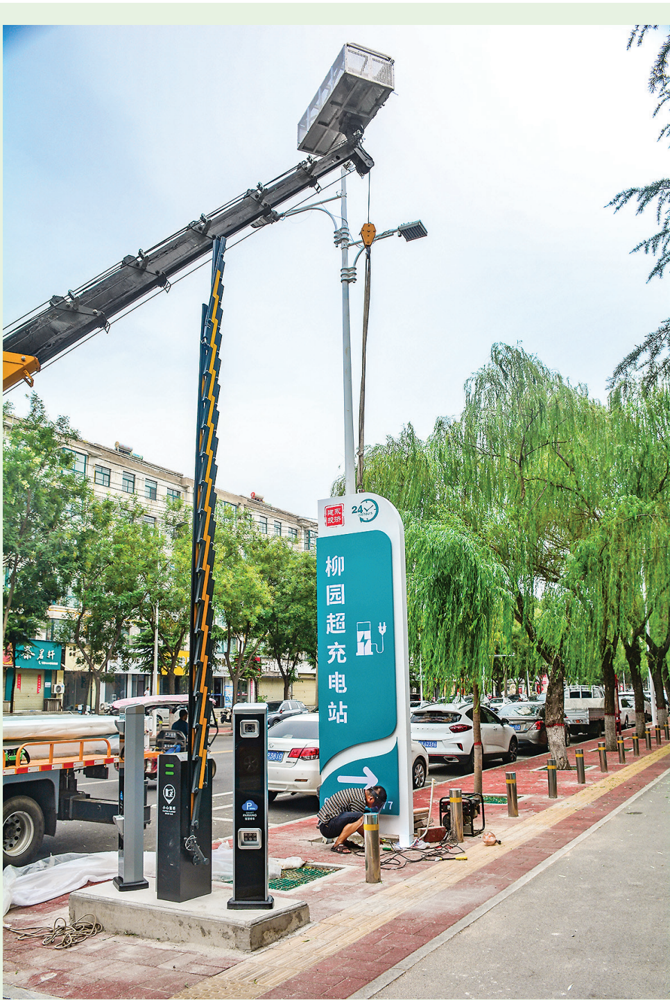
8月21日,永济市市政部门施工人员在柳园正门西侧进行充电站站牌的吊装与焊接。
