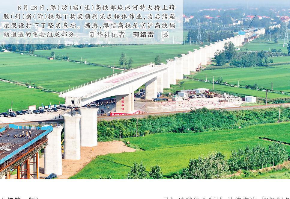
8月28日，雄（坊）宿（迁）高铁郑汴河特大桥上跨胶（州）新（沂）铁路T构梁顺利完成转体作业，为后续箱梁架设打下了坚实基础。据悉，潍宿高铁是京沪高铁辅助通道的重要组成部分。新华社记者 郭绪雷 摄
