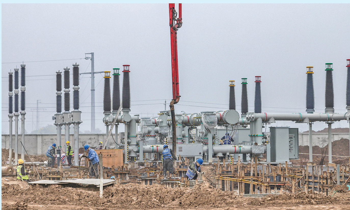
11月10日,运城200MW电站项目建设现场,工人们在抢抓进度,加紧建设。 该项目位于运城经济技术开发区,总容量达200MW/301.75MWh,分两期建成。目前,一期工程总投资13亿元,主要用于电力系统调频,储能技术采用中时能量型电化学储能与短时功率型飞轮储能构成的混合储能系统,预计本月底可通电带电,12月底完成一期工程建设任务。该项目投用后,将充分发挥两种储能技术不同的能量和功率特性,确保在不同电力需求波动,能够提供强有力的调节支持。 本报记者 金玉敏 摄
