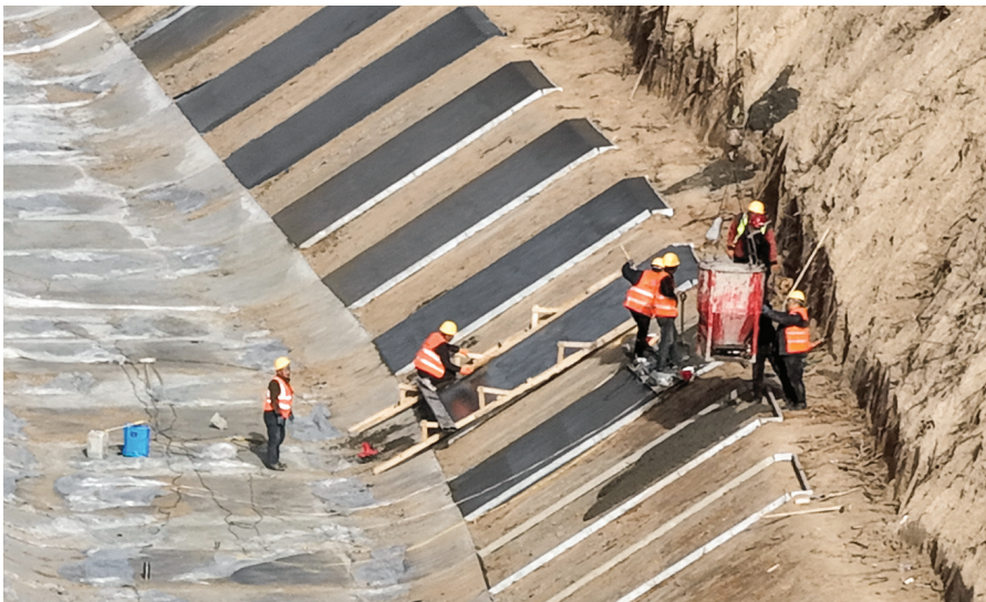
11月25日，在尊村引黄干渠水浇段升级改造项目施工现场，工人们紧张有序地进行U型渠道的混凝土浇筑作业，振捣、抹平各环节紧密衔接。该项目顺利推进，将为来年灌区的防汛、灌溉及供水工作夯实基础。 特约摄影 程永仁 摄
