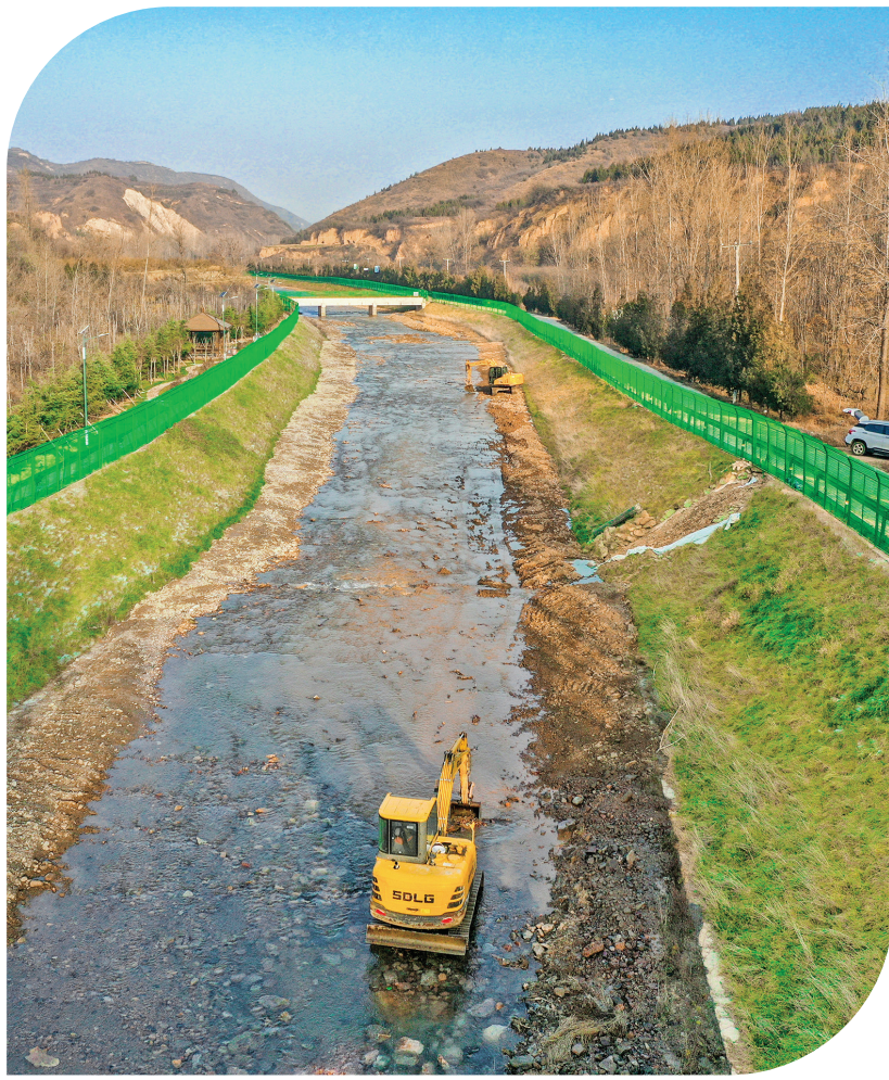
11月30日,夏县水源地保护与治理修复项目(白沙河段工程)施工现场,机械车辆在进行河道疏浚作业。
