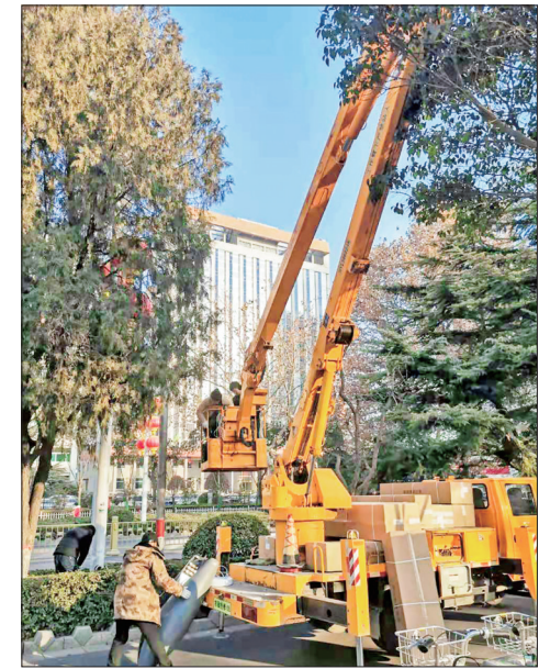
▲施工人员在更换石墨烯路灯 祁克宁 摄
