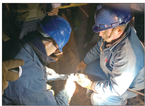
▲抢修人员在装接设备 崔恬雪 摄
