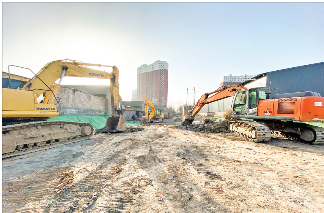
▲施工机械启动作业 刘凯华 摄
