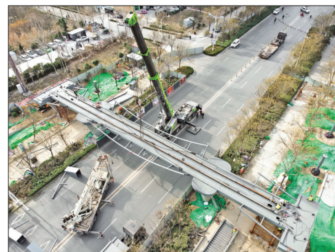
▲1月9日,大型吊车进行人行桥梁吊装。 记者 闫鑫 摄
