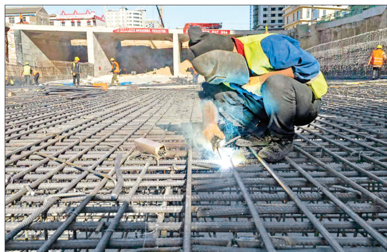
▲施工人员在焊接引道U形槽地基钢筋模具 祁克宁 摄
