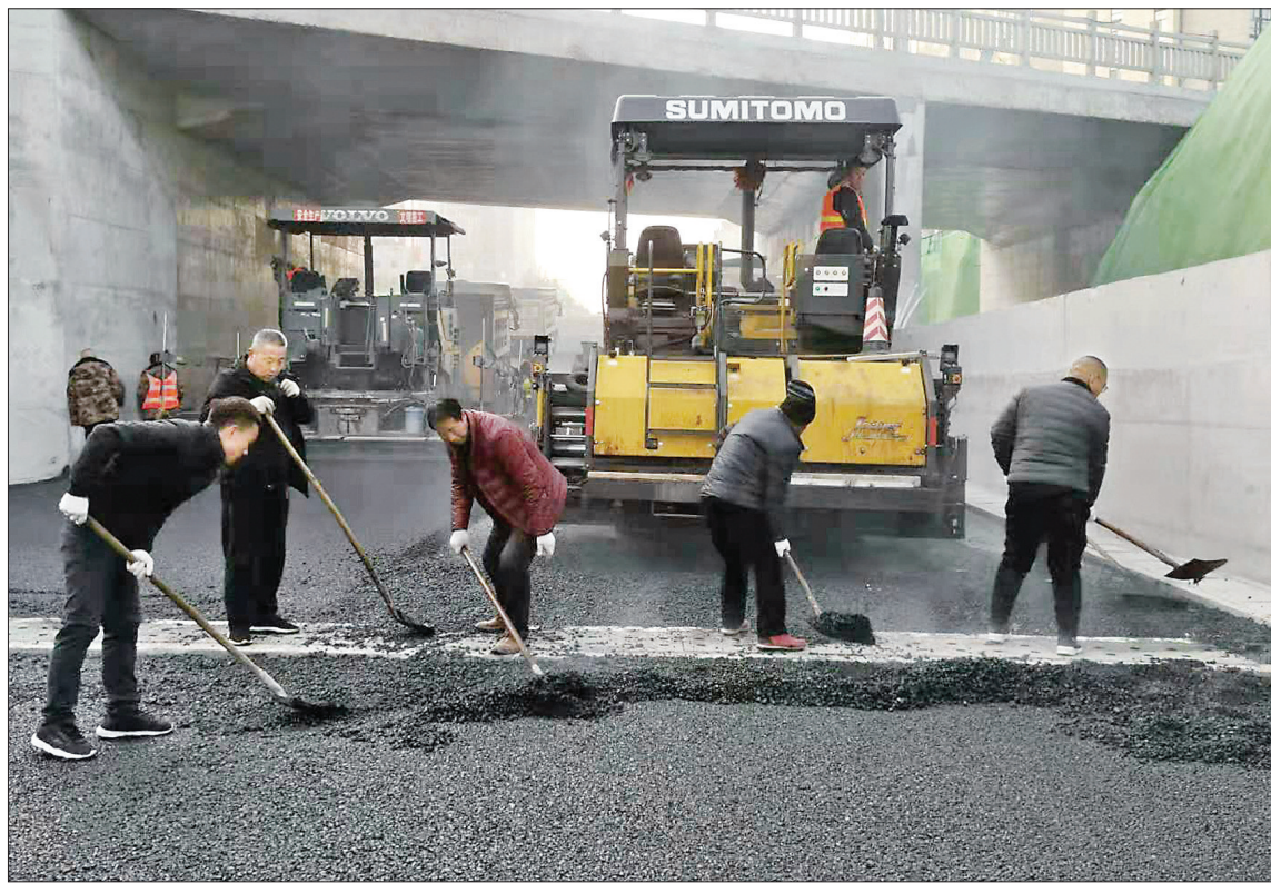
▲摊铺机对主车道进行铺油作业
