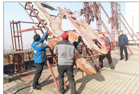
▲施工人员拆除户外广告牌
