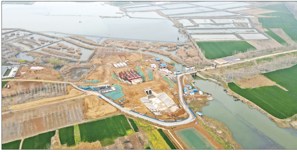
▲三月十日拍摄的蚌埠市固镇县怀洪新河水系洼地治理工程施工现场 新华社记者 陈诺 摄
