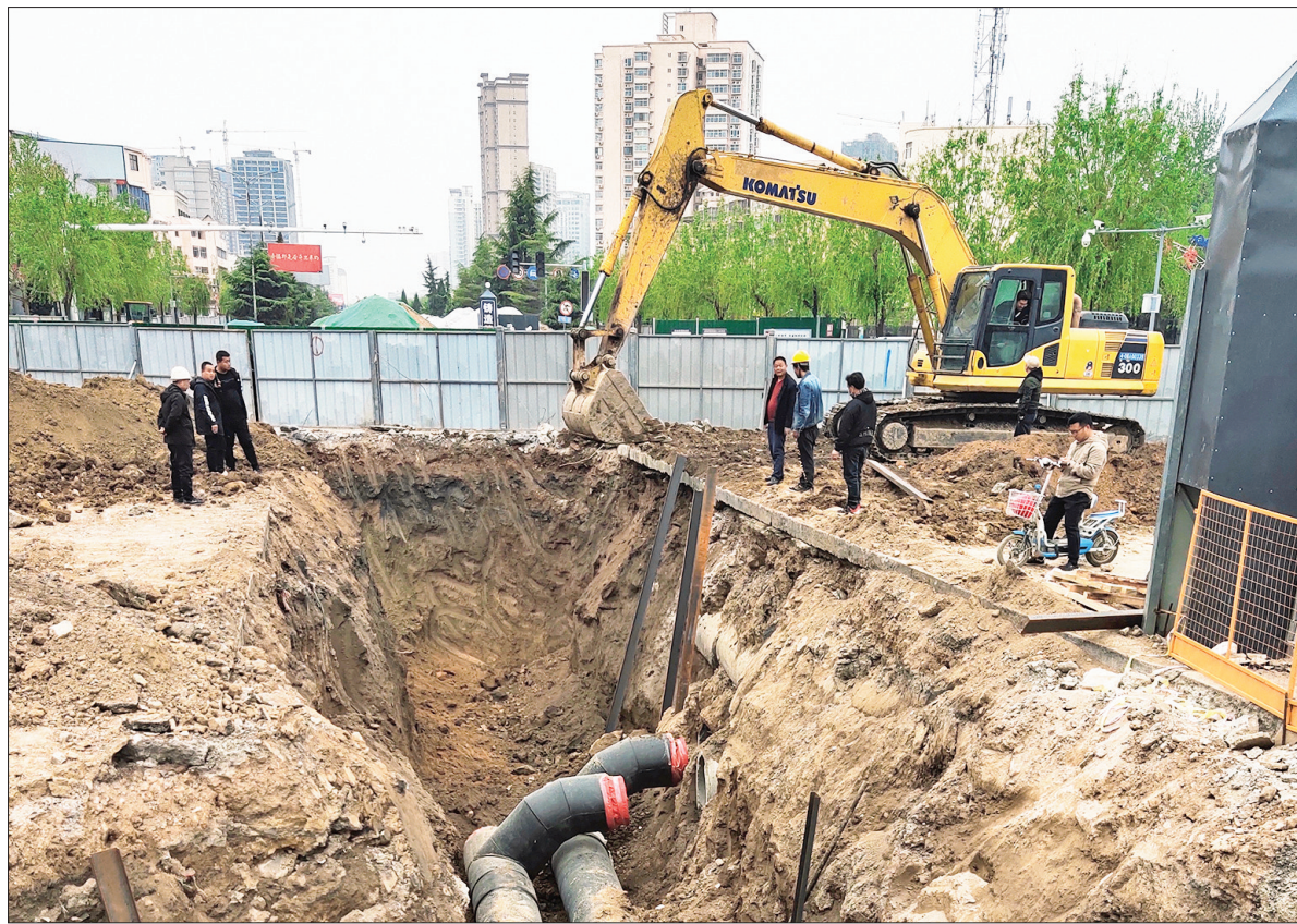
▲挖掘机开挖管沟
