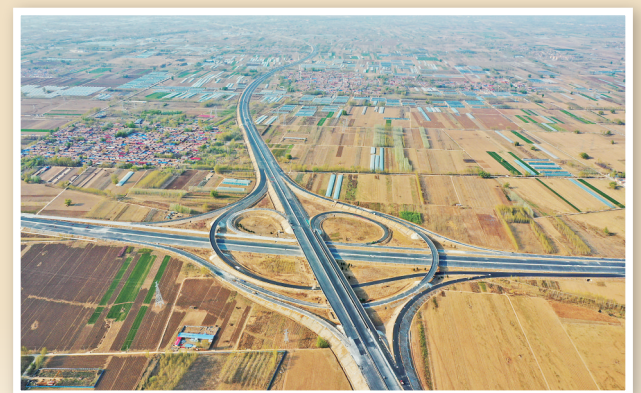
▲京德高速(一期工程)千人目互通建设现场(4月7日摄)
