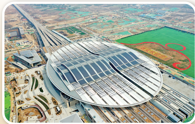
▲4月9日拍摄的京雄城际铁路雄安新区站
