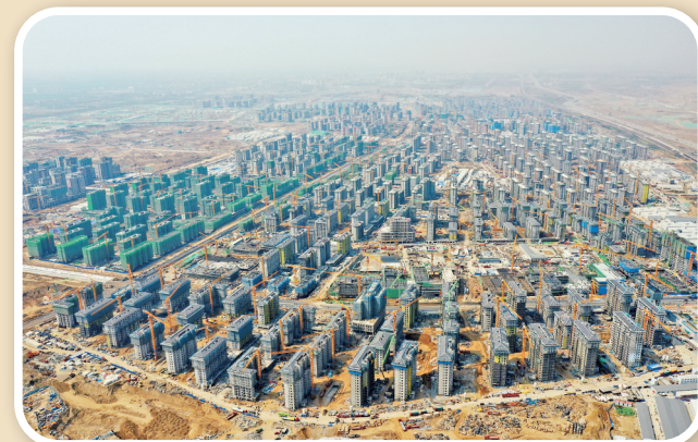
▲4月8日拍摄的雄安新区容东片区安置房项目建设现场
