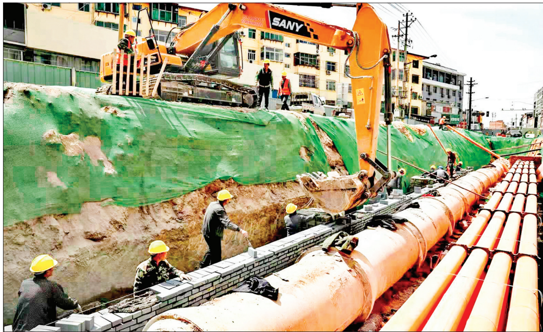
▲施工人员建设污水管涵
