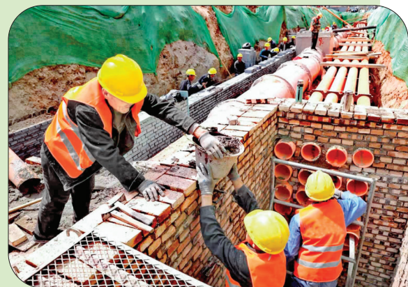
▲工人建设电力排管检查井
