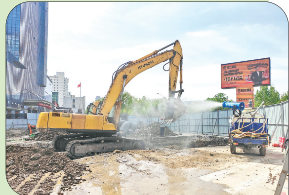
▲机械开挖顶管作业
