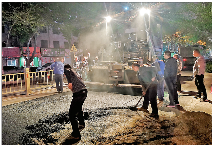
▲摊铺机铺油作业
