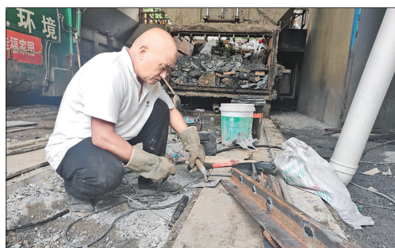
工人在改造垃圾中转站污水处理系统
