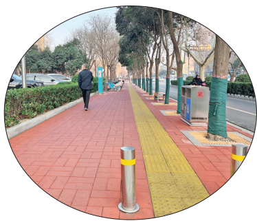
▲提升改造后的人行道
