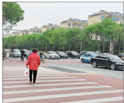
▲修复完成的路面
