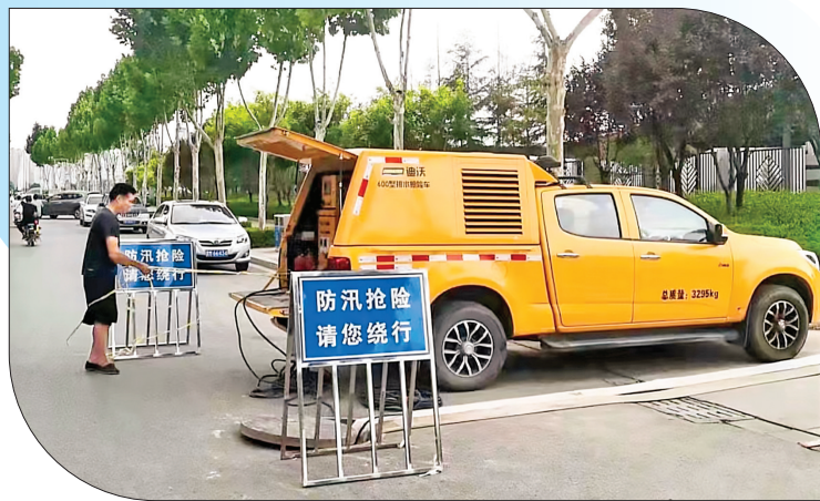
▲在市区涑水街与库东路交叉口附近,工作人员提前使用移动泵车进行抽排,并放好警示牌,拉好隔离带。
