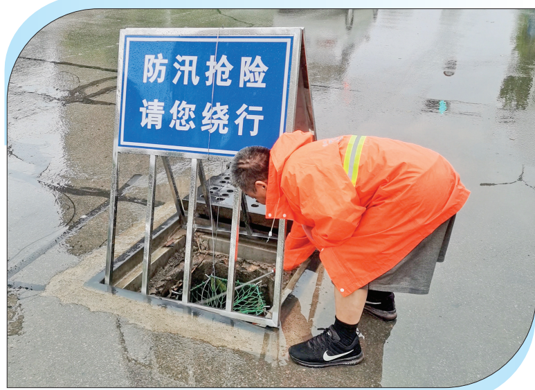
▲工作人员清理防坠网上的垃圾
