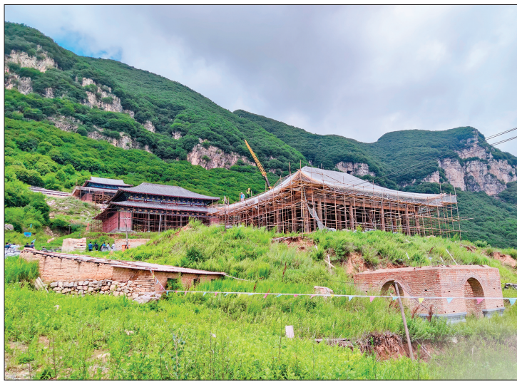
▲紧张施工中的九峰山道教文化建设项目 王捷 摄
