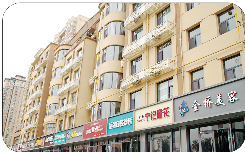
立面更新后的解放路
