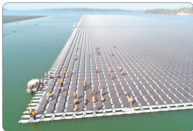
▲2021年1月23日，施工人员检查中泰两国联合承建的泰国乌汶府诗琳通大坝综合浮体光伏项目的太阳能板安装情况。 新华社发
