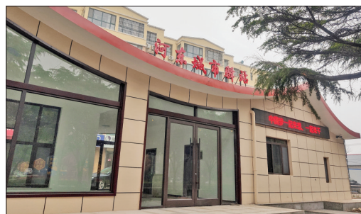
新建的装配式城市驿站
