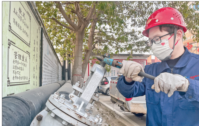
工作人员一次管网开阀作业
