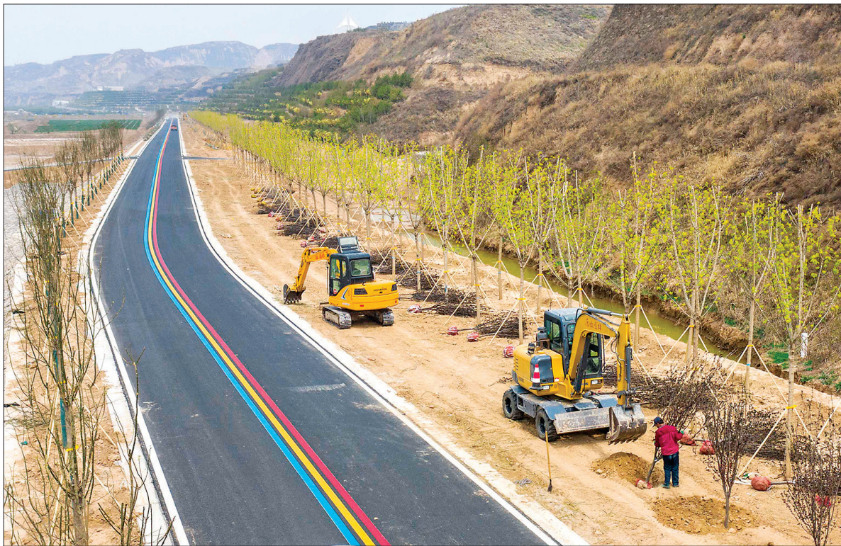
▲4月4日，工人在黄河一号旅游公路临猗段栽植树木。
