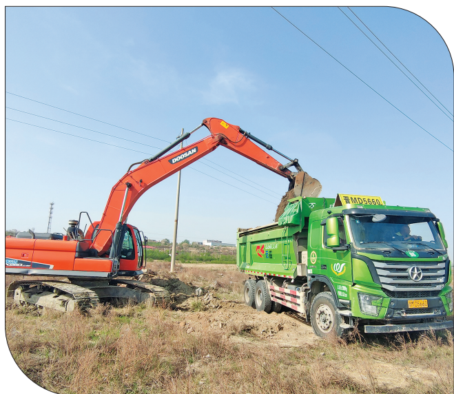
▲清运建筑垃圾
