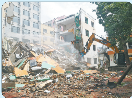
▲拆除违法建筑
