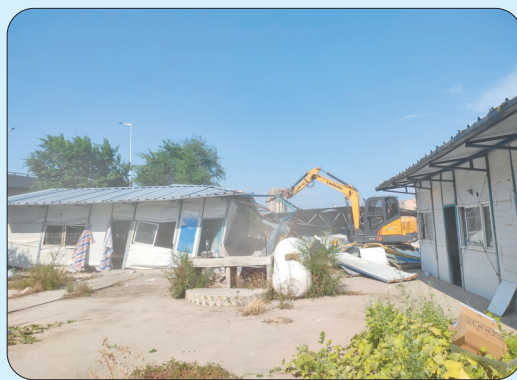
▲拆除违章棚亭
