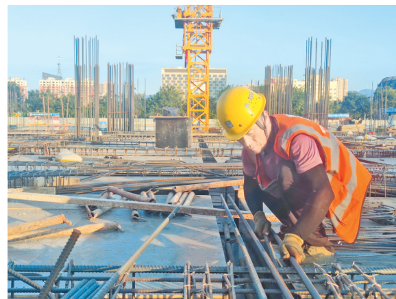
工人捆绑钢筋
