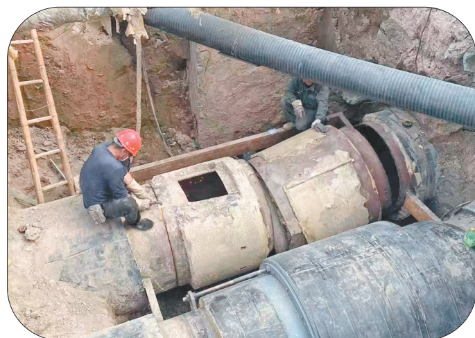
工人在现场施工
