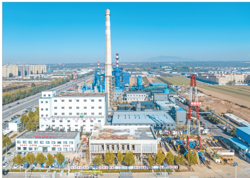
▲临猗能源岛地热趸热一期项目现场
