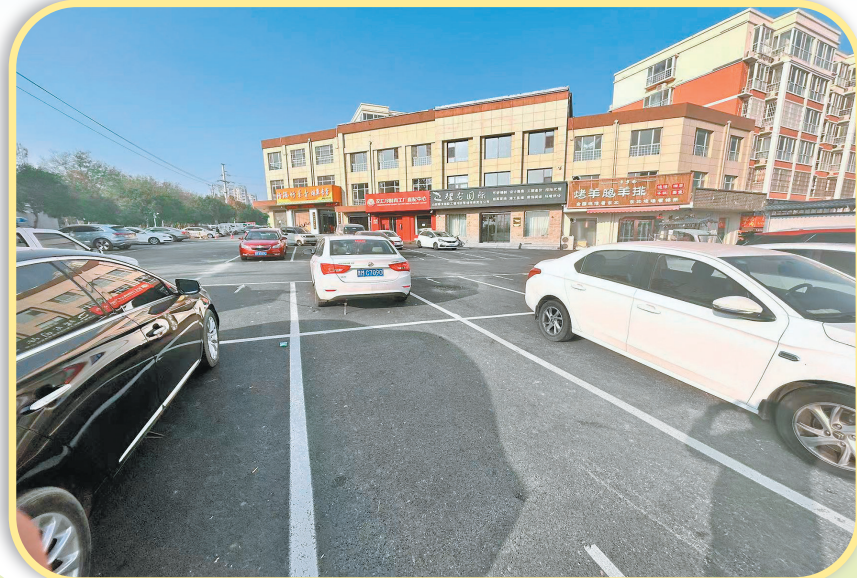
▲新铺设的柏油路
