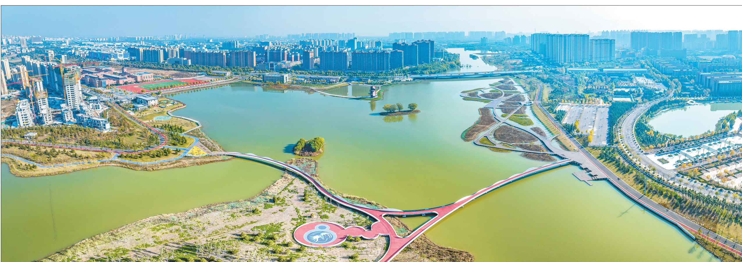
▲官道河生态修复与整治工程樊村水库段项目的建设提升了防洪排涝能力，生态湿地的区域面貌也焕然一新，呈现林水相依的景象。
