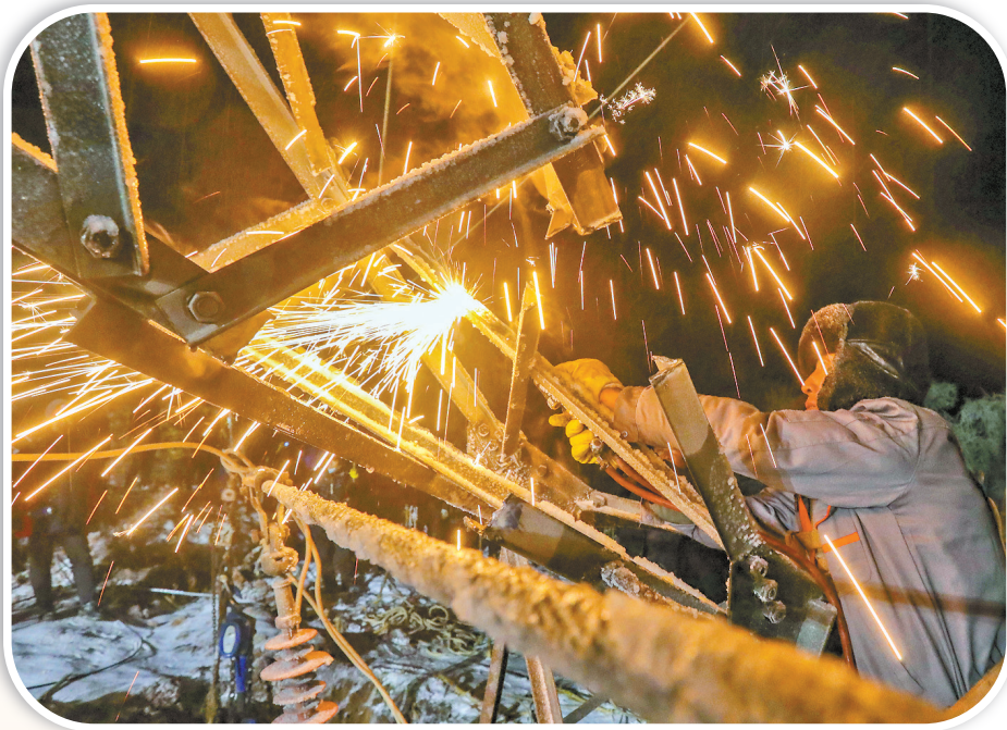
▲切割拆除损坏基塔
