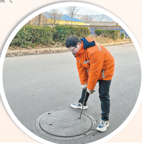
▼一次管网阀门井巡线
