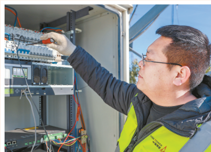
▲中国铁塔运维人员检查通信基站
