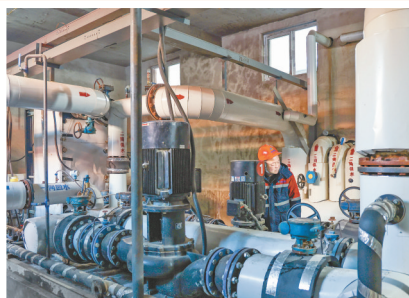
▲换热站供热巡检
