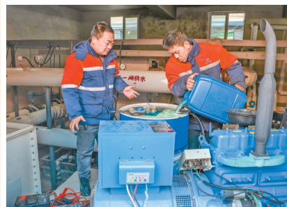
▲维护人员为换热站发电机加油
