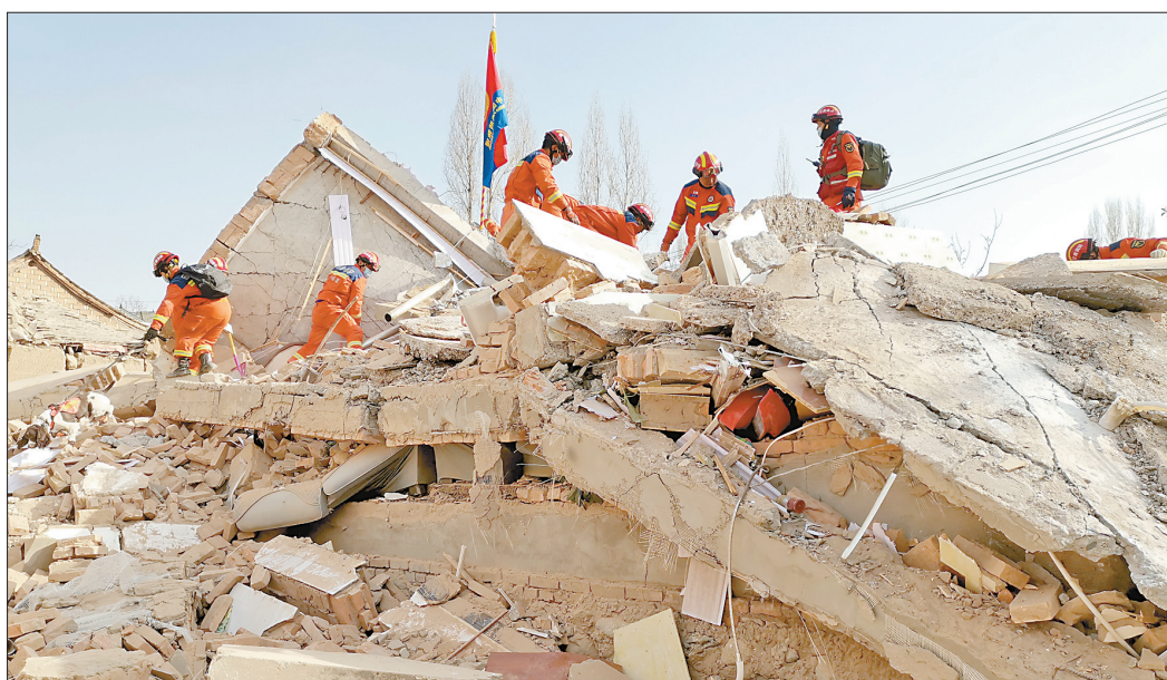
◀ 12月19日,救援人员在甘肃省临夏州积石山县大河家镇进行救援。 新华社记者 张领 摄
