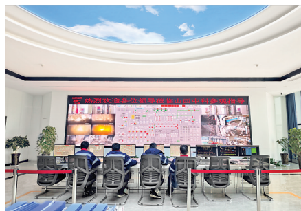
▲中控室内查看实时数据
