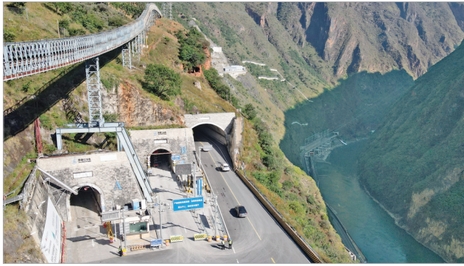
▲这是雅砻江畔，中国锦屏地下实验室所在的锦屏山隧道口(11月8日摄)。新华社记者 胥冰洁 摄
