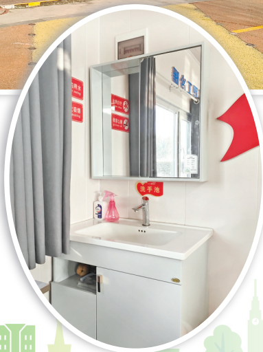
▲驿站内的洗手池
