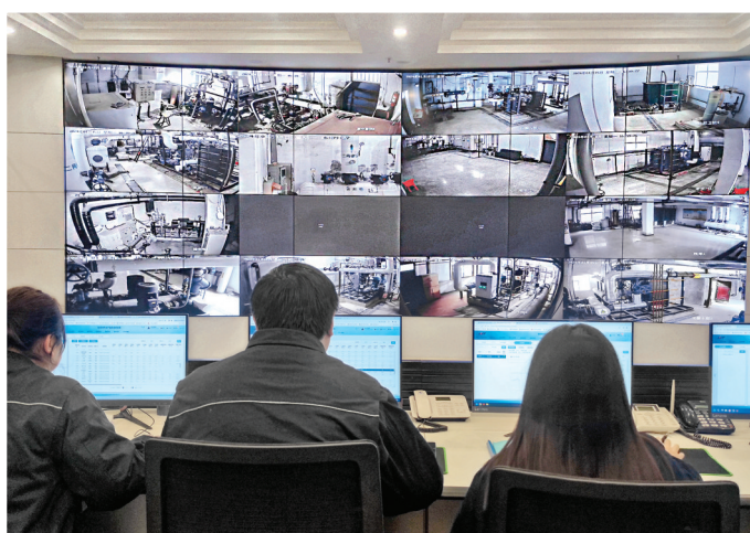
▲调度室查看供热情况
