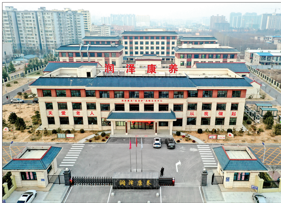
▲平陆县养老服务中心项目俯瞰图
